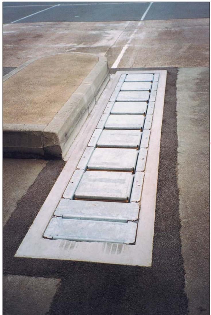
Eine ARS-Einheit besteht aus einem Betonrahmen, 8 ARS-Klappkeilen, sowie 2 variablen Einsatzteilen/ Ausgleichsstücke. Die auf Straßenniveau eingebauten feuerverzinkten Stahlteile haben keine scharfen Kanten. Die einzelnen Stahlkeile sind in dem Fertigteil-Betonrahmen so arretiert, daß bei den Schwenkbewegungen der Rad-Klappkeile keine Scherkanten entstehen.
