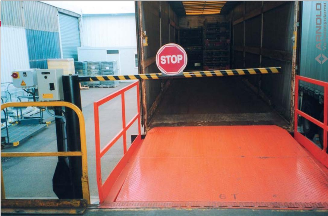
Die pneumatische Sicherungsschranke stoppt die Einfahrt in den LKW.
